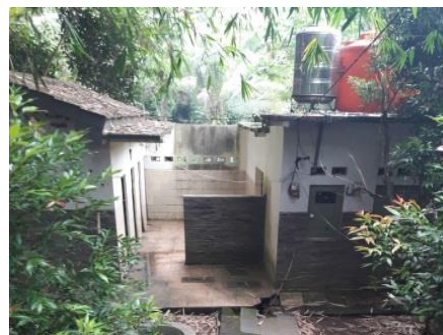
Gambar 7 Fasilitas RO di IPAL Cikobak Indah (Kelurahan Bubulak)
